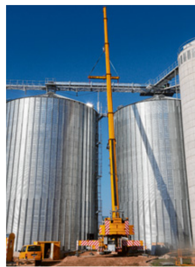
Ein Autokran hebt die Versorgungsbänder der beiden neuen Silos an ihren Standort. Foto: Michael Kienastl
